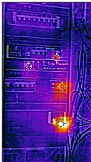
Ce tableau électrique a été photographié simultanément par le capteur visuel standard et par le capteur thermique de la K1.
