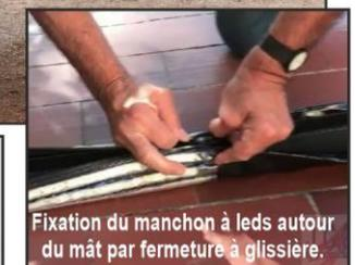
Fixation du manchon à leds autour du mât par fermeture à glissière.
