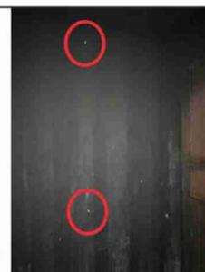
Ici placées à 0.8 m et 1.90 m de hauteur, les 2 sondes ne dépassent que de 20 mm à l'intérieur du caisson.
